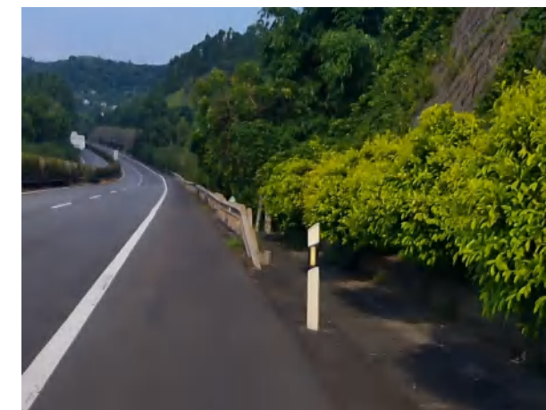
图3-3 K2076+319~K2100+322段路侧钢护栏端部现状
