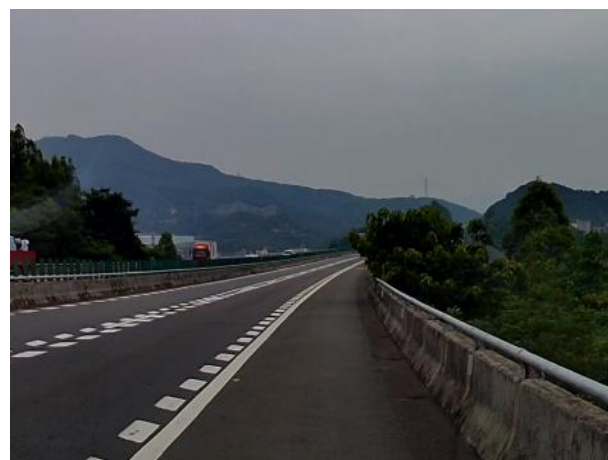
图3-7 沈海高速公路福泉段部分桥梁护栏现状
