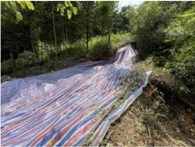
图 5 后缘水沟损毁
